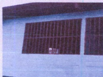
Foto 3: Mantenimiento a balcones de metal
