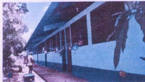
Foto 8: Pintura en muros exteriores e interiores
