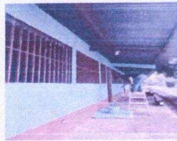
Foto 8: Pintura en muros exteriores e interiores
