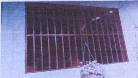
Foto 3: Mantenimiento a balcones de metal
