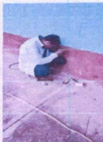
Foto 11: Sustrucción de tomacorrientes dobles
