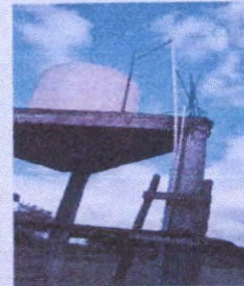
Foto 4: Sustitución de tubería línea principal
