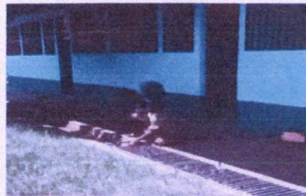
Foto 12: Mantenimiento a reposaderas
