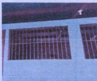
Foto 3: Mantenimiento a balcones de metal
