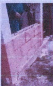
Foto 5: Repello en muro y pared de poso
