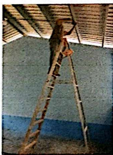
Foto 5: sustitucion de plafoneras y focos ahorradores
