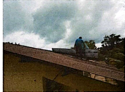
Foto 2: sustitucion de lámina por lamina troquelada de aluzinc calibre 26
