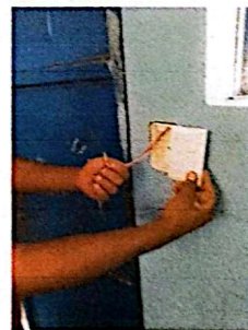
Foto 6: Sustitucion de interruptor doble
