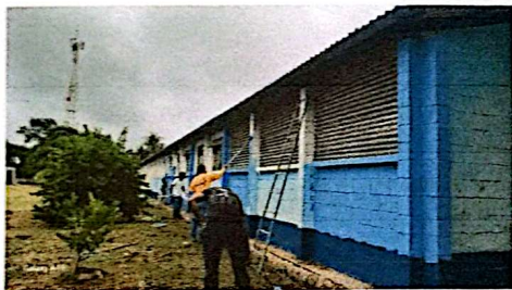
Foto 3: pintura en muros interior y exterior
