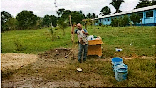
Foto1: Sustitucion de pila de cemento de dos lavaderos
