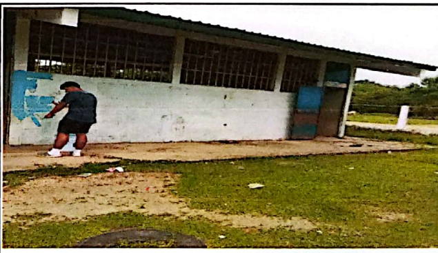
Foto 06. Pintura en muros exteriores
