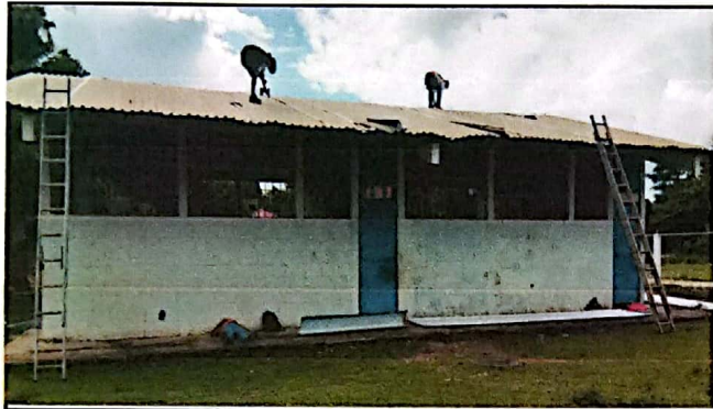
Foto 01. Instalación de Lámina troquelada Aluzinc
