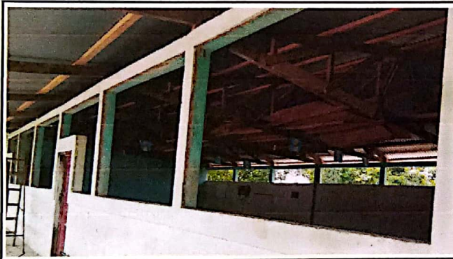
Foto 03. Fabricación e instalación de metros de balcon
