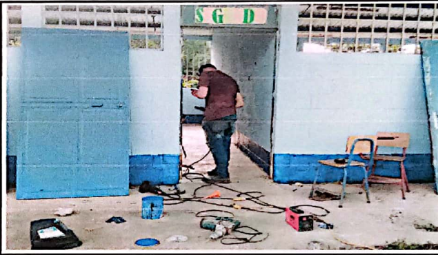
Foto 04. Sustitución de Puerta
