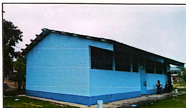
Foto 06. Pintura en muros exteriores
