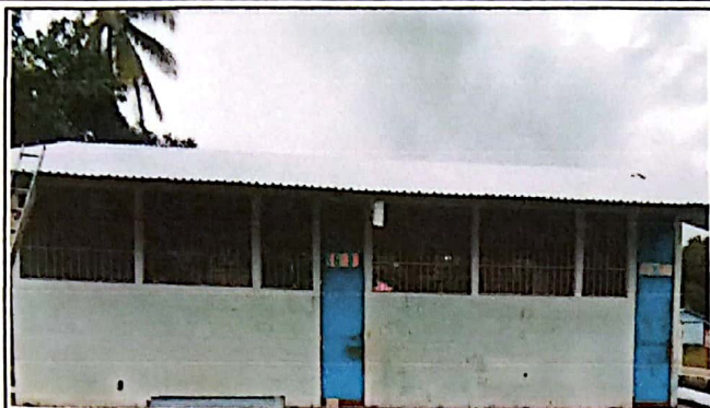
Foto 01. Instalación de Lámina troquelada Aluzinc
