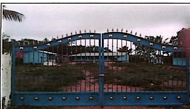
Foto 05. Sustitución de Portón en entrada principal
