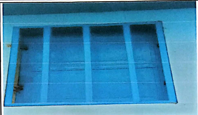
Foto 02. Sustitución de Ventana
