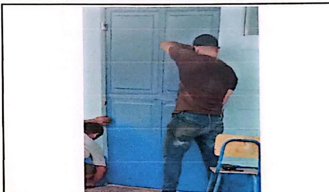
Foto 04. Sustitución de Puerta
