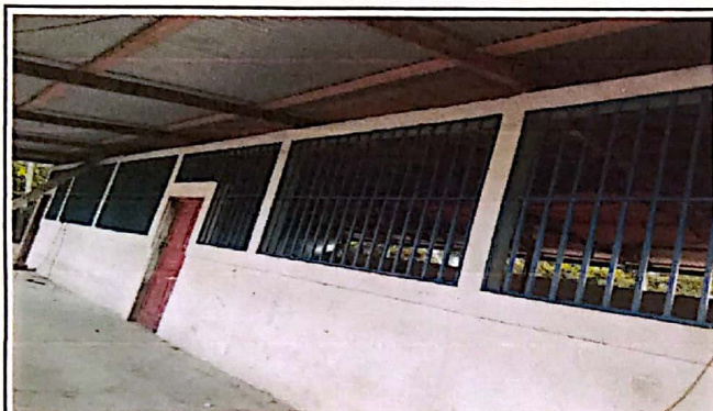
Foto 03. Fabricación e instalación de metros de balcon
