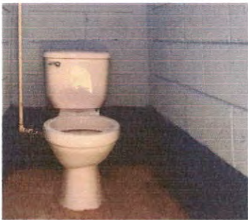
SUSTITUCIÓN DE ACCESORIOS INODORO
