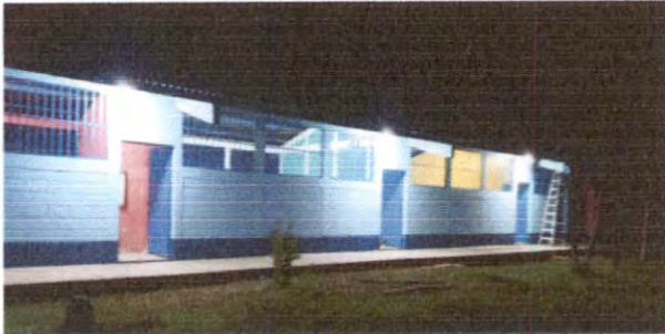
MANTENIMIENTO ESTRUCTURA PUERTAS DE METAL
