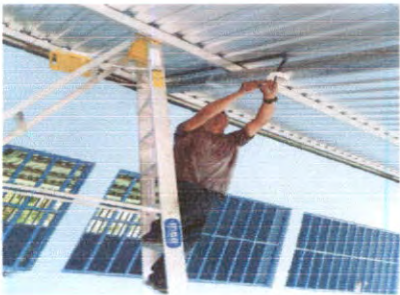
SUSTITUCIÓN DE FOCOS AHORRADORES
