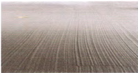
SUSTITUCIÓN DE PISO DE TORTA DE CONCRETO
