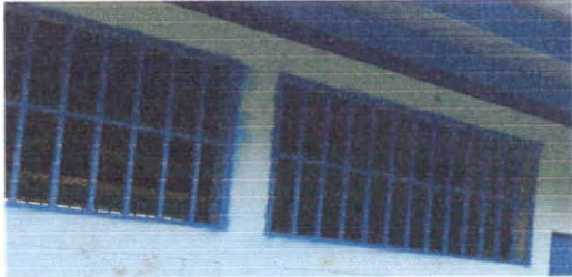
MANTENIMIENTO A BALCONES DE METAL
