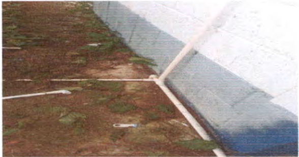
SUSTITUCIÓN DE TUBERIA PRINCIPAL AGUA POTABLE
