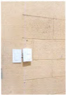
SUSTITUCION DE INTERRUPTORES SIMPLES
