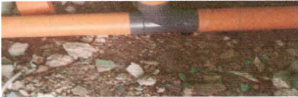
SUSTITUCIÓN DE TUBERIA LINEA PRINCIPAL AGUAS NEGRAS
