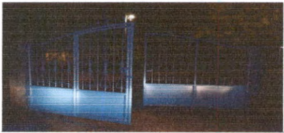
MANTENIMIENTO A PORTON DE METAL
