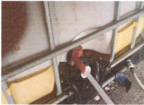
SUSTITUCIÓN DE DEPOSITO DE AGUA
