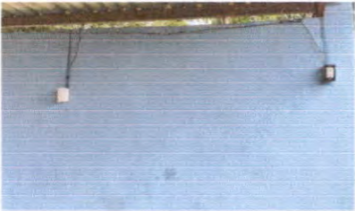
SUSTITUCIÓN DE TOMACORRIENTES DOBLES
