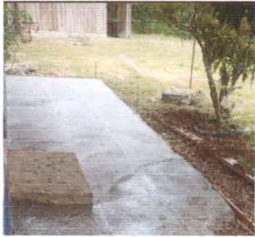
SUSTITUCIÓN DE TORTA DE CEMENTO
