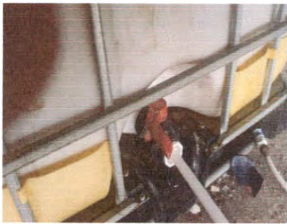
SUSTITUCIÓN DE DEPOSITO DE AGUA
