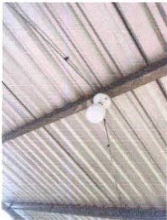
SUSTITUCIÓN DE FOCOS AHORRADORES
