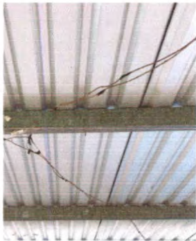
SUSTITUCIÓN DE DUCTO ELECTRICO + ACCESORIOS
