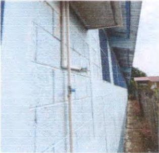
SUSTITUCIÓN DE TUBERIA LINEA PRINCIPAL AGUA POTABLE
