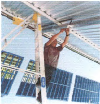
SUSTITUCIÓN DE PLAFONERAS
