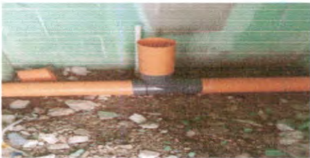
SUSTITUCIÓN DE TUBERIA LINEA PRINCIPAL AGUAS NEGRAS
