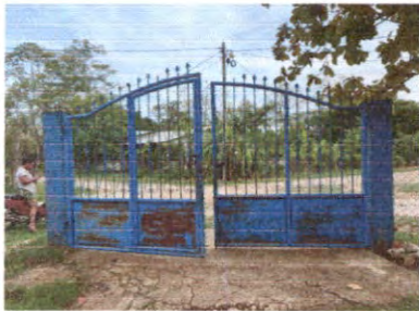
MANTENIMIENTO A PORTON DE METAL
