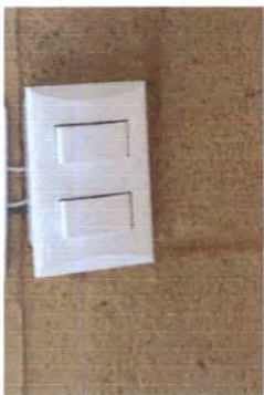
SUSTITUCIÓN DE INTERRUPTORES SIMPLES
