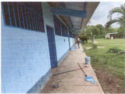
PINTURA EN EXTERIOR
