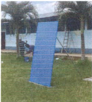
MANTENIMIENTO ESTRUCTURA PUERTAS DE METAL
