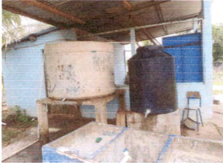
SUSTITUCIÓN DE DEPOSITO DE AGUA
