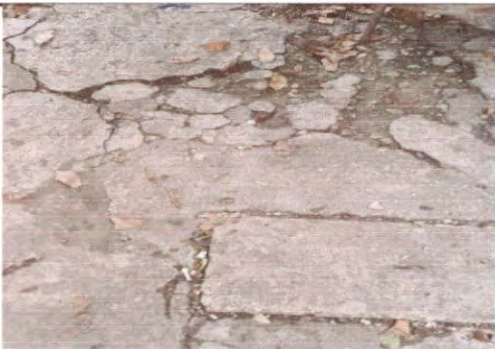
SUSTITUCIÓN DE PISO DE TORTA DE CONCRETO
