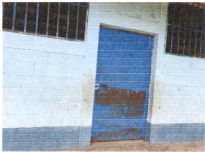
MANTENIMIENTO ESTRUCTURA PUERTAS DE METAL
