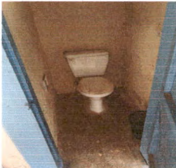
SUSTITUCION ACCESORIOS INODORO
