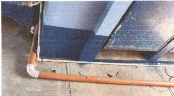
SUSTITUCIÓN DE TUBERIA LINEA PRINCIPAL AGUAS NEGRAS
