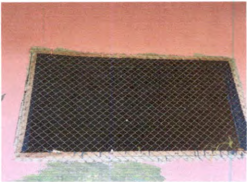
SUSTITUCIÓN DE BALCON DE METAL
