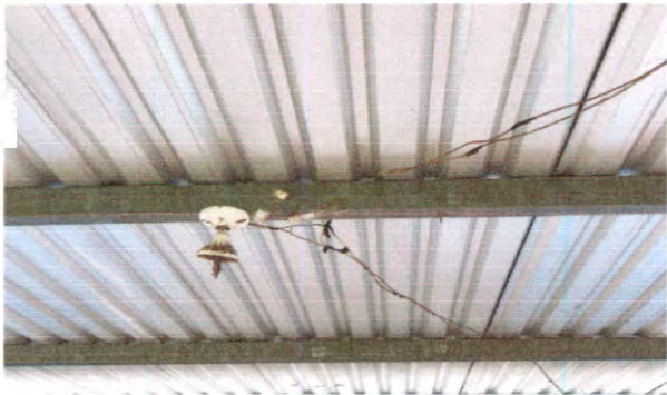
SUSTITUCIÓN DE DUCTO ELECTRICO + ACCESORIOS
