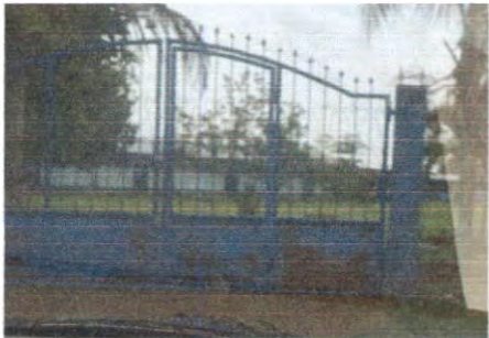
MANTENIMIENTO A PORTON DE METAL
