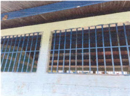
MANTENIMIENTO A BALCONES DE METAL
