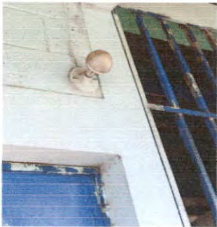
SUSTITUCIÓN DE PLAFONERAS
