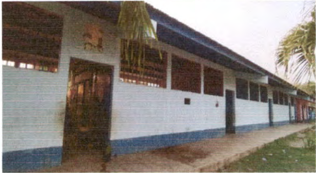
PINTURA EN EXTERIOR
