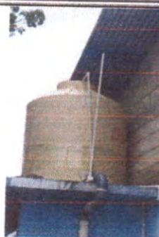
Foto 8: sustitución de deposito de agua
