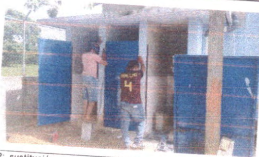
Foto 2: sustitución; puerta de los baños
