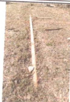
Foto 14: sustitución de tubería de aguas negras
