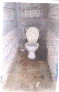
Foto 7: sustitución de inodoros (tasas)
