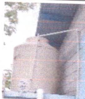
Foto 8: sustitución de deposito de agua
