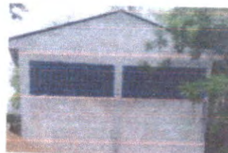
Foto 4: repello de cocina de exterior e interior
