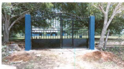
Foto7 :Sustrucción de porton de metal de metal
