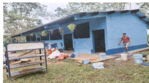
Foto 8: Pintura en muros exteriores e interiores de aulas y escenario
