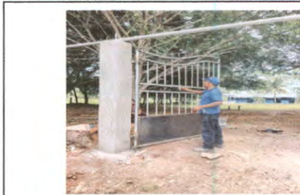
Foto7 :Sustitución de porton de metal de metal
