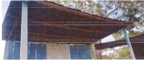
Foto 4: Sustitución de estructura de soporte de madera, por metal modulo escenario
