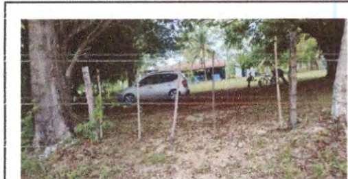
Foto 7 :Sustrucción de porton de metal de metal
