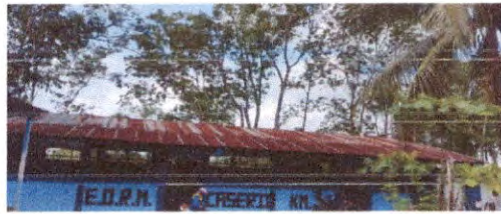
Foto 2: Sustitución de capote de lamina troquelada
