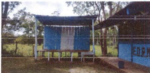
Foto 5: Sustitución de lamina, por lamina troquelada aluzinc calibre 26 escenario
