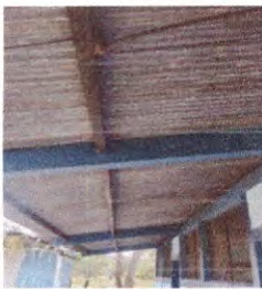
Foto 3: Sustitución de elementos de fijación
