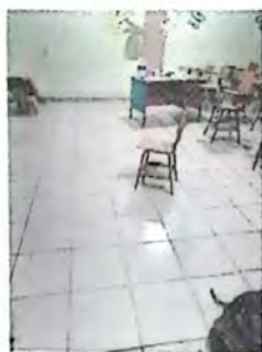
Foto 5: sustición de piso de cemento líquido por piso ceramico
