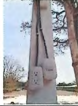
Foto 14: Sustitución de interruptores simples
