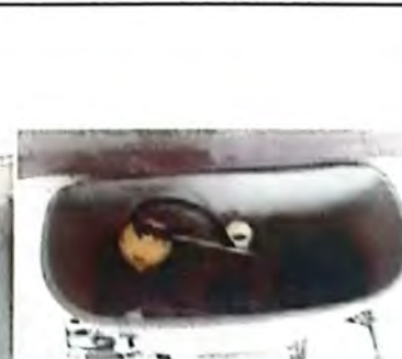
Foto 6: Sustitución de accesorio de Inodoro
