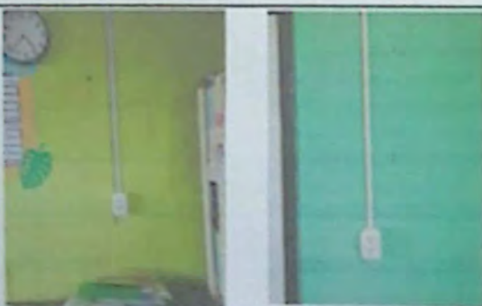
Foto 11: Sustitución de tomacorriente doble
