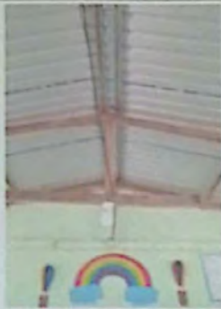
Foto 7: Reparación de cableado eléctrico
