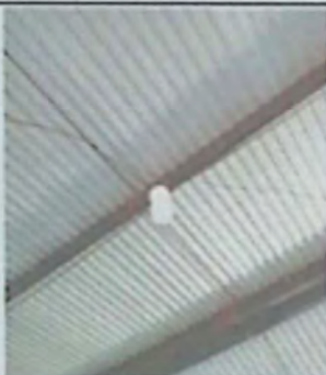
Foto 9: Sustitución de focos ahorradores
