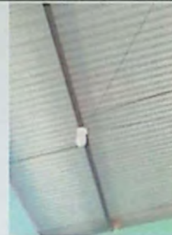
Foto 8: Sustitución de plafonera
