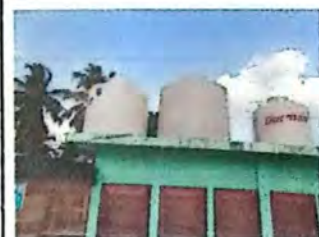
Foto 3: Sustitucion de deposito de Agua de 1700 lt
