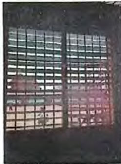
Foto 13: Sustitución de Ventanas de madera por metal mas vidrio
