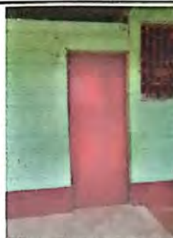
Foto 4: Sustitución de puerta de metal
