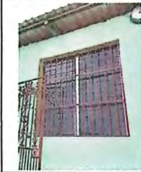
Foto 13: Sustitución de Ventanas de madera por metal mas vidrio
