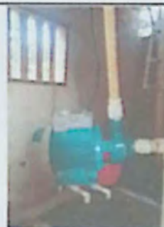
Foto 10: Sustitución de bomba de agua
