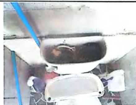
Foto 6: Sustitución de accesorio de inodoro
