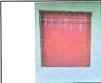
Foto 13: Sustitución de Ventanas de madera por metal mas vidrio
