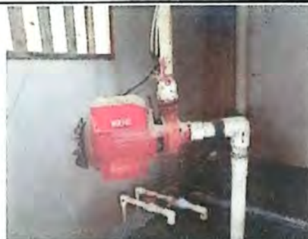
Foto 10: Sustitución de bomba de agua
