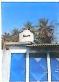
Foto 3: Sustitucion de deposito de Agua de 1700 lt
