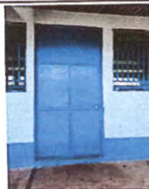
Foto 4: Mantenimiento a puertas
