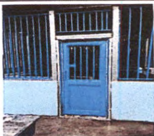
Foto 3: Sustitución de puerta
