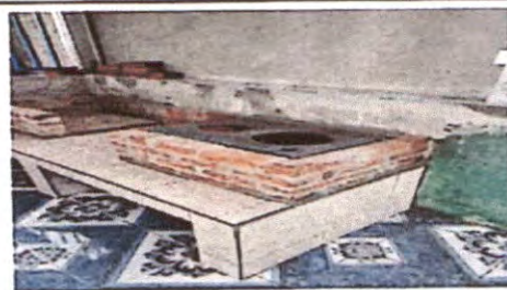
Foto 10: Reparación de estufa Rural
