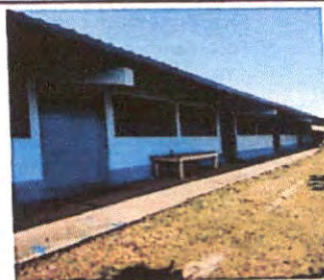
Foto 6: Pintura en muros exteriores e interiores
