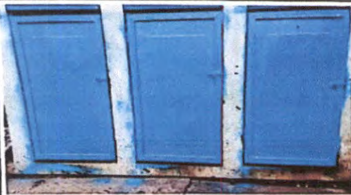
Foto 7: Sustitución de puerta de baño
