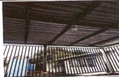
Foto 12: Reparación de cableado eléctrico
