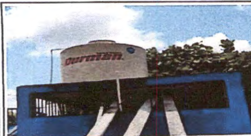
Foto 9: Sustitución de depósito de agua de 1700 litros
