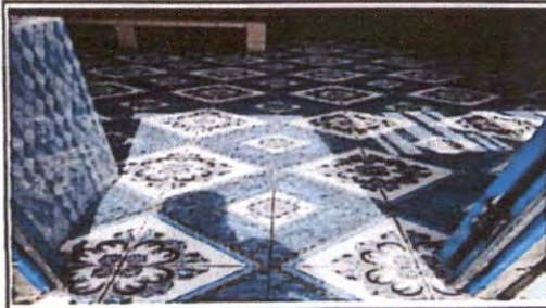
Foto 8: Sustitución de piso cerámico
