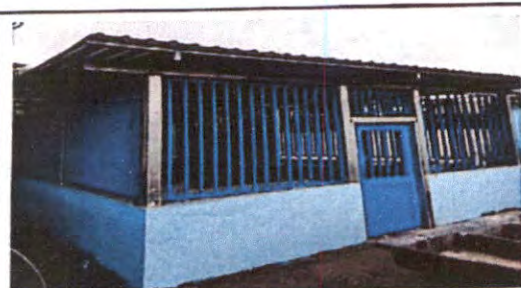
Foto 5: Sustitución de balcones de metal
