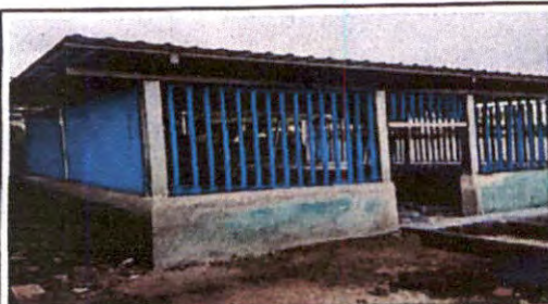
Foto 5: Sustitución de balcones de metal
