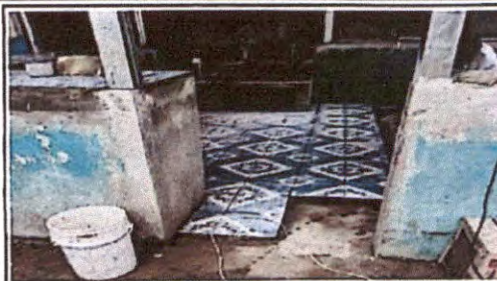
Foto 8: Sustitución de piso cerámico
