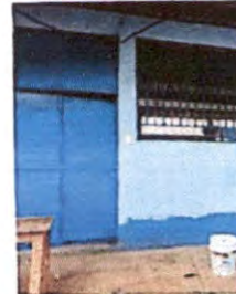
Foto 4: Mantenimiento a puertas
