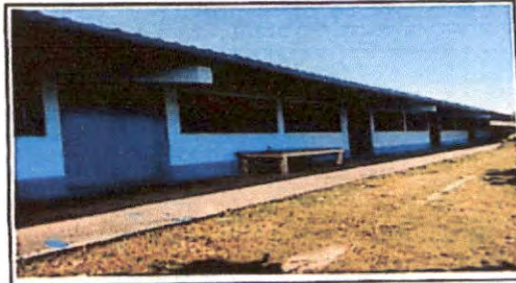
Foto 6: Pintura en muros exteriores e interiores
