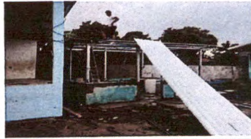
Foto 2: Sustitución de estructura de soporte de madera, por metal y sustitución de lámina
