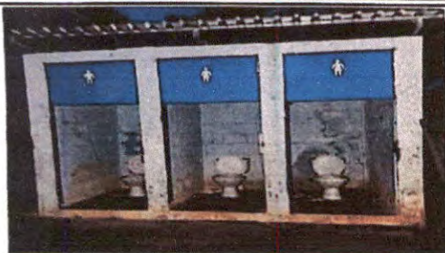
Foto 7: Sustitución de puertas de baño
