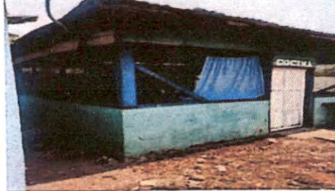
Foto 2: Sustitución de estructura de soporte de madera, por metal y sustitución de lámina
