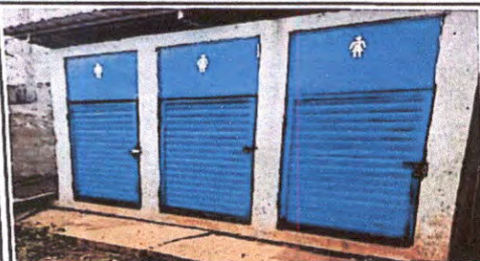
Foto 7: Sustitución de puertad de baños
