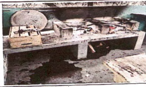
Foto 9: Reparación de estufa rural
