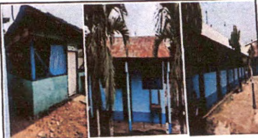
Foto 6: Pintura en muros exteriores e interiores
