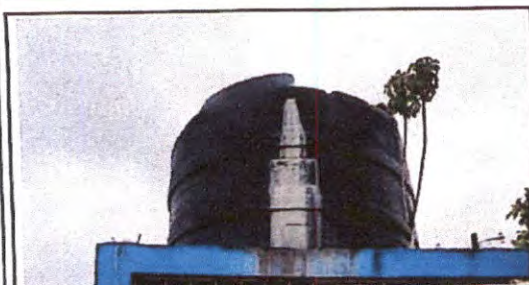
Foto 9: Sustitución de deposito de agua de 1700 litros
