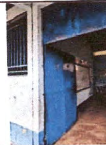
Foto 4: Mantenimiento a puertas
