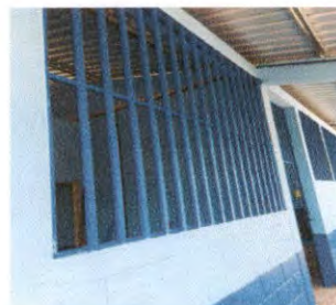
Foto 6: Mantenimiento a balcones de metal
