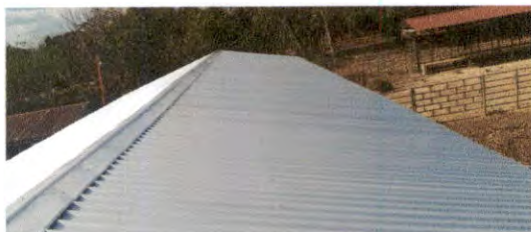
Foto1: Sustitución de lamina, por lamina troquelada aluzinc calibre 26 modulo de aulas
