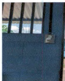
Foto 11: Sustitución de interruptor simple
