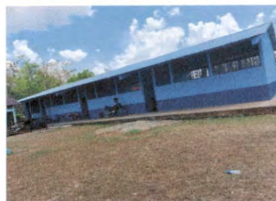
Foto 8: Pintura en muros interiores y exteriores aulas
