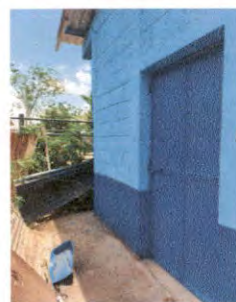
Foto 4: Sustitución de puerta de metal
