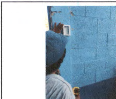
Foto13: Sustitución de tomacorriente doble
