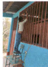
Foto 6: Mantenimiento a balcones de metal
