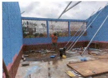
Foto 8: Pintura en muros interiores y exteriores aulas
