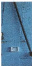
Foto 11: Sustitución de interruptor simple
