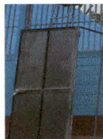
Foto 4: Sustitución de puerta de metal
