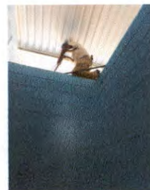
Foto 10: Sustitución de focos ahorradores
