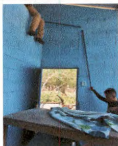
Foto 9: Sustitución de plafoneras
