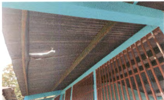
Foto 1: Cubierta de Lamina
