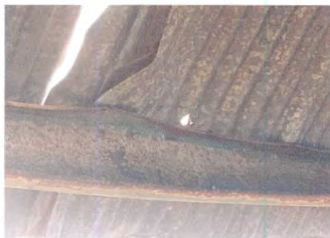
Foto 5: Estructura de Techo
