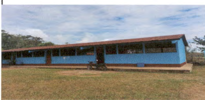
Foto 6: Pintura de Muros, Interiores y Exteriores
