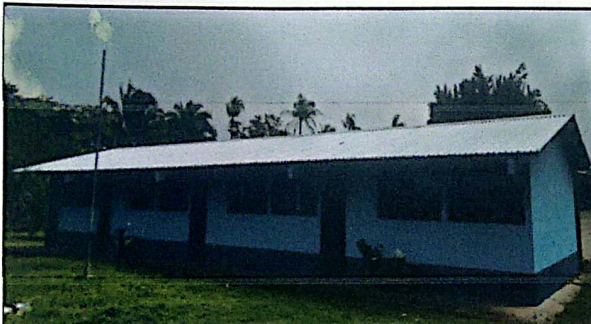
Foto 3: Pintura de muros exteriores e interiores
