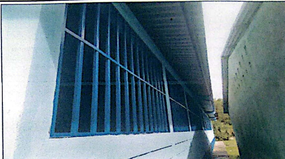
Foto 2: Mantenimiento de balcones de Metal
