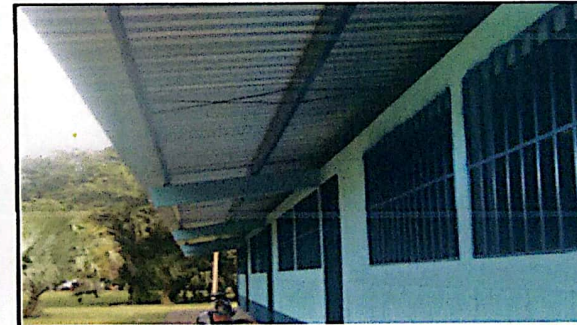
Foto 6: Mantenimiento a estructura de soporte de metal
