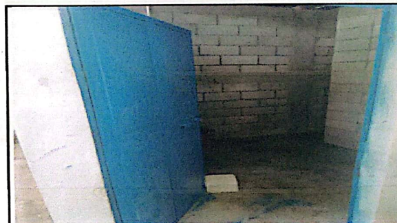
Fabricacion e instalacion de puertas
