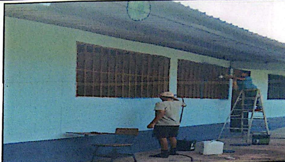
Foto 2: Mantenimiento de balcones de Metal
