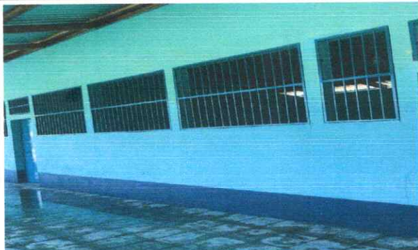
Foto1: Sustitución de balcones-Fabricación e instalación de balcones de hierro en ventana
