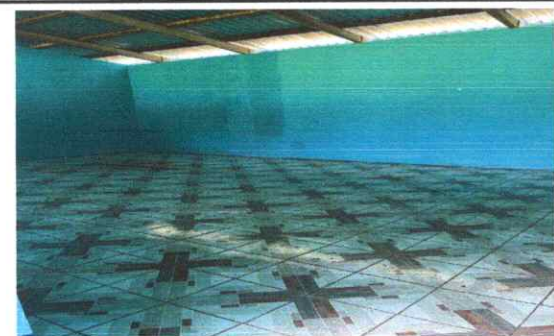
Foto 5: Sustitución de piso de torta de concreto
