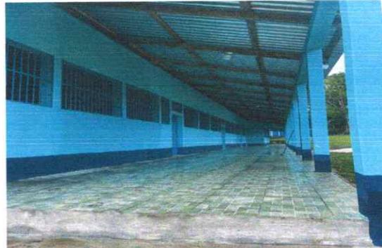
Foto 2: Sustitución de piso de cemento liquido
