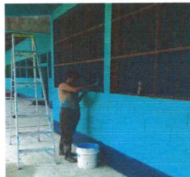
Foto 4: Pintura en muros exteriores e interiores
