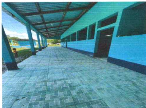
Foto 3: Sustitución de puertas- Fabricación e instalación
