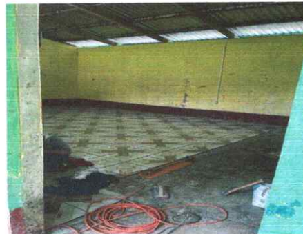
Foto 2: Sustitución de piso de cemento líquido
