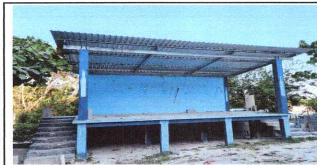
Foto 5: Sustrucción de lámina, por lámina troquelada, sustrucción de estructura de soporte de madera por metal
