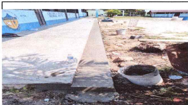
Foto1: Reparación banqueta frontal lado izquierdo
