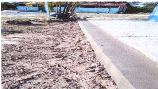
Foto 4: Reparación banqueta frontal lado izquierdo
