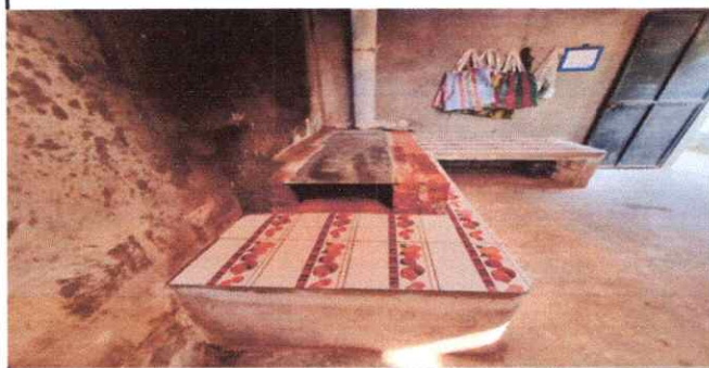
Foto 3: Cambio de azulejo
