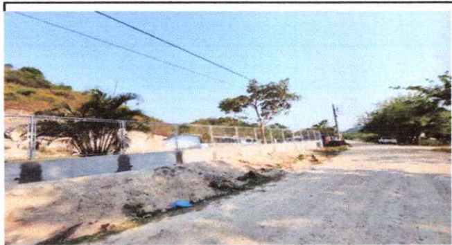
Foto1: Elaboración de cerco ecológico perimetral
