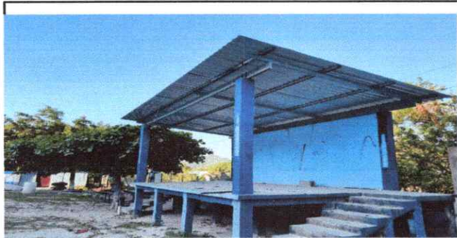
Foto 3: Sustrucción de lámina, por lámina troquelada, sustrucción de estructura de soporte de madera por metal
