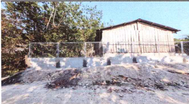
Foto 2: Elaboración de cerco ecológico perimetral, parte frontal izquierda
