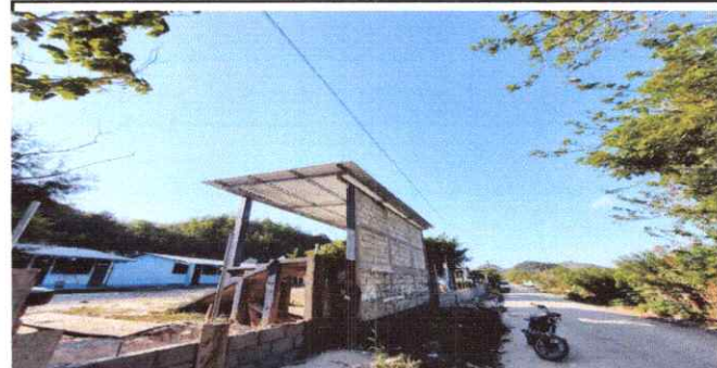
Foto 4: Sustrucción de lámina, por lámina troquelada, sustrucción de estructura de soporte de madera por metal
