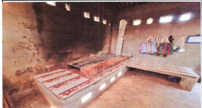
Foto 2: Sustitución de estufa rural completa, incluye chimenea
