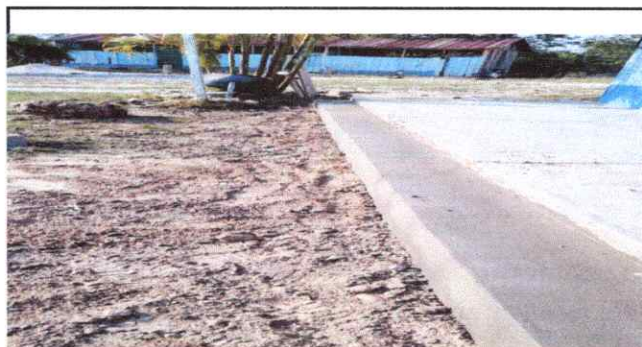
Foto 6: Reparación banqueta frontal lado izquierdo
