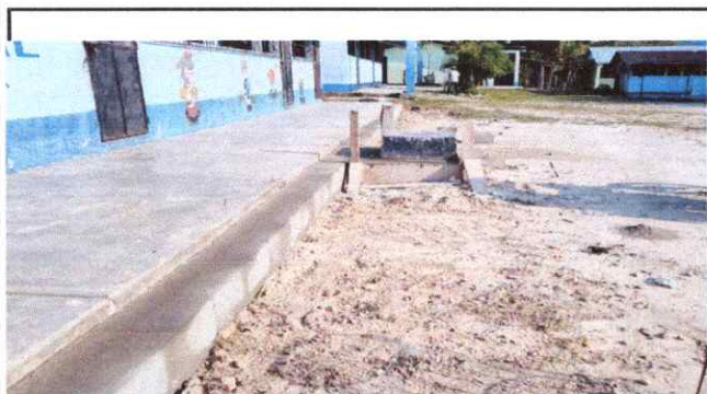
Foto 3: Reparación banqueta frontal
