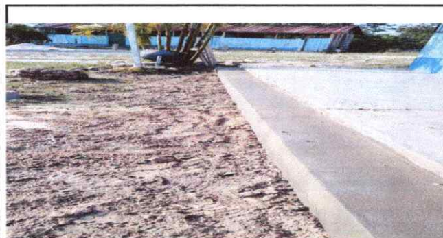
Foto 5: Reparación banqueta frontal lado izquierdo
