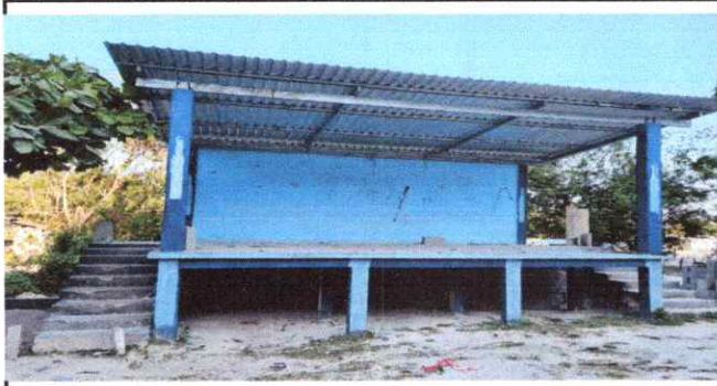
Foto 1: Sustrucción de lámina, por lámina troquelada, sustrucción de estructura de soporte de madera por metal
