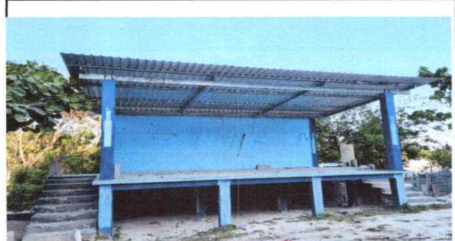
Foto 2: Sustrucción de lámina, por lámina troquelada, sustrucción de estructura de soporte de madera por metal
