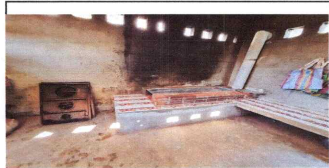
Foto 6: Cambio de planchas
