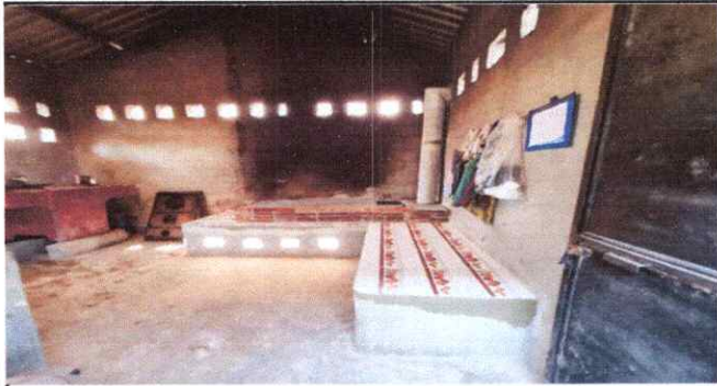
Foto1: Sustitución de estufa rural completa, incluye chimenea
