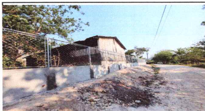
Foto 3: Elaboración de cerco ecológico perimetral, parte frontal izquierda
