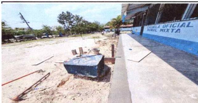
Foto 2: Reparación banqueta frontal lado derecho
