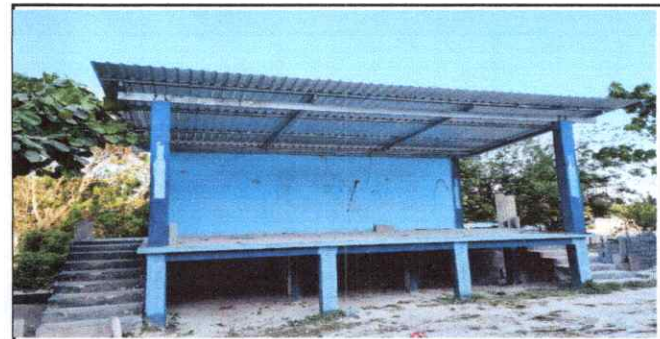
Foto 6: Sustrucción de lámina, por lámina troquelada, sustrucción de estructura de soporte de madera por metal
