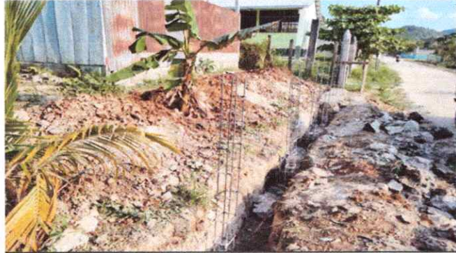
Foto1: Fundición de columnas
