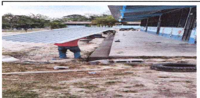
Foto 5: Fundición y repello de banqueta
