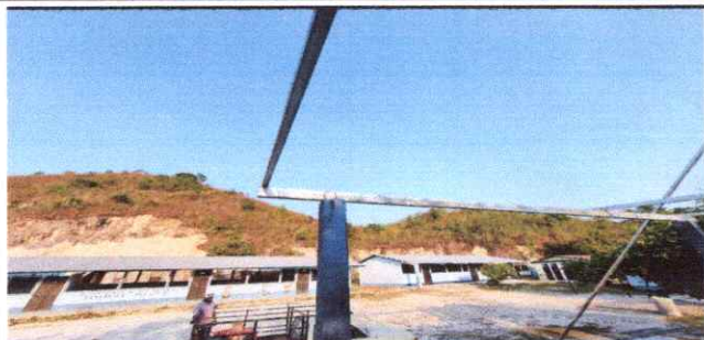
Instalación es estructura portante de metal
