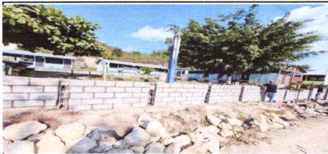
Foto 5: Levantado de hiladas de block
