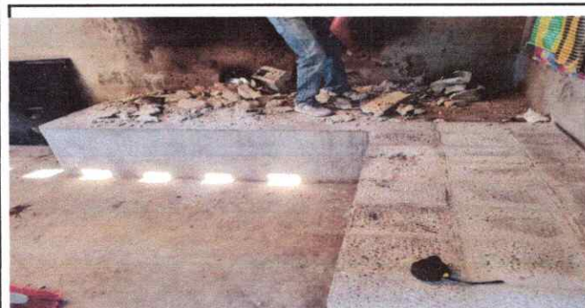
Foto 3: Reparación de estufa rural completa
