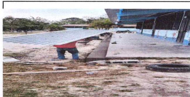
Foto 6: Fundición y repello de banqueta
