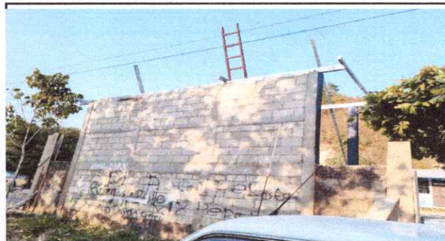
Foto 4: Instalación es estructura portante de metal
