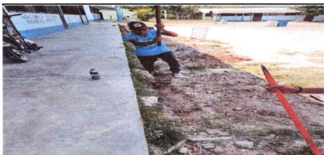
Foto 3: Sanjeo, restructuración banqueta
