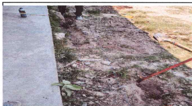
Foto 4: Sanjeo, restructuración banqueta
