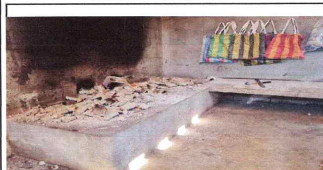
Foto 5: Reparación de estufa rural completa
