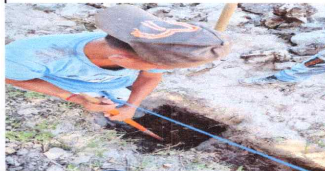
Foto 4: sanjeo de columnas
