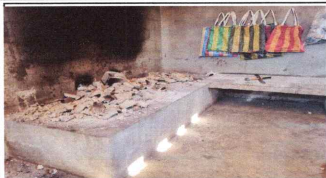
Foto 1: Reparación de estufa rural completa
