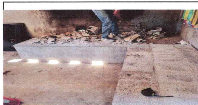
Foto 6: Reparación de estufa rural completa
