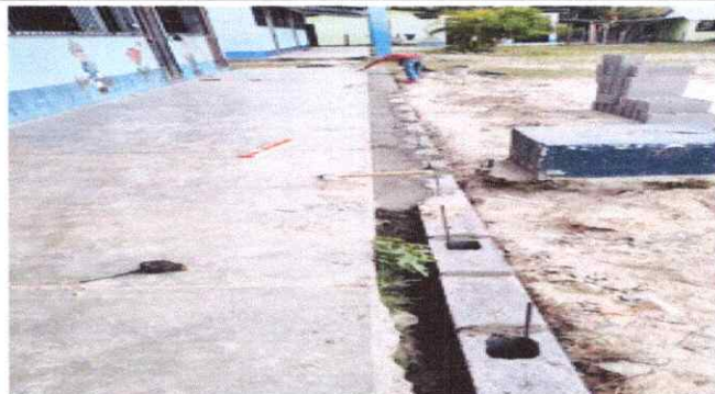
Foto 2: Restructuración de banqueta
