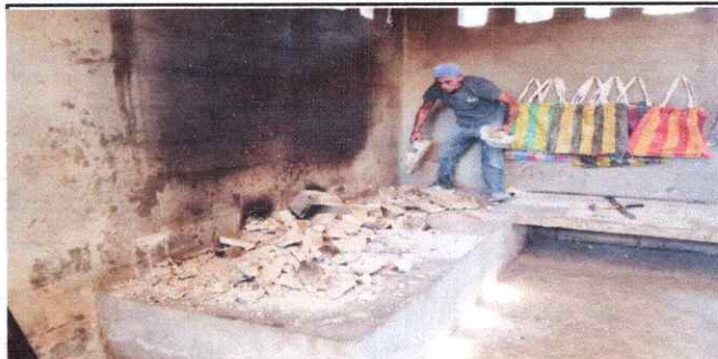
Foto 2: Reparación de estufa rural completa
