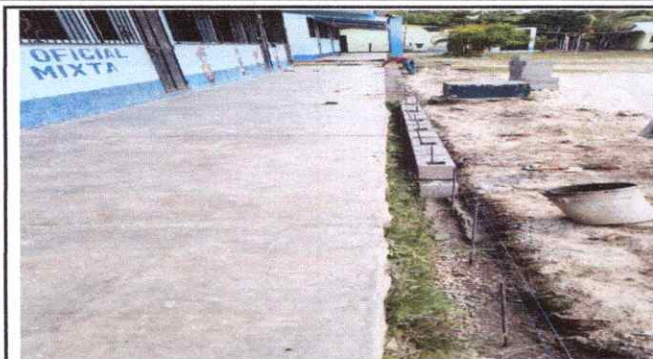
Foto 1: Restructuración de banqueta
