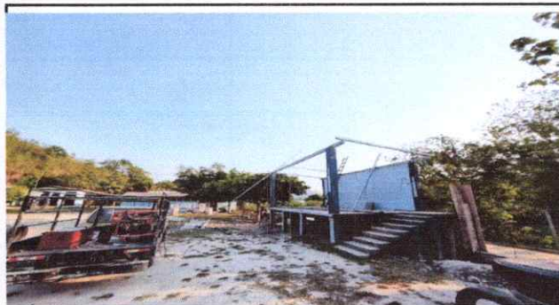
Foto 2: Instalación es estructura portante de metal
