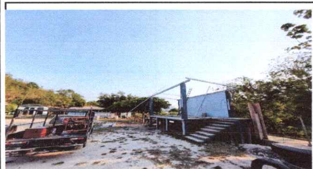
Foto 5: Instalación es estructura portante de metal
