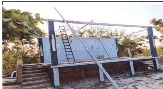
Foto 3: Instalación es estructura portante de metal
