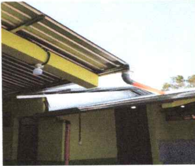
Foto 3: Mantenimiento a estructura de soporte de metal
