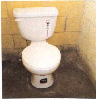
Foto1: Sustrucción de accesorios inodoro (contra llave, tubo de abasto y tanque)
