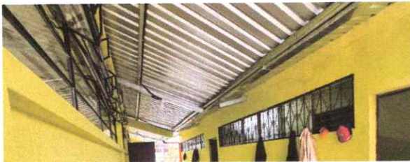
Foto 5: Sustrucción de soporte o pescante de metal para canal
