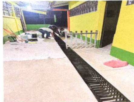
Foto 6: Reparación de cuneta de concreto
