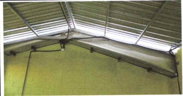
Foto 2: Instalación de estructura de soporte de metal
