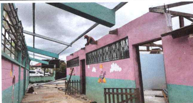
Foto 3: Mantenimiento a estructura de soporte de metal
