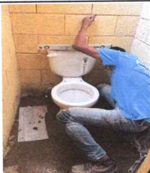
Foto1: Sustitución de accesorios inodoro (contra llave, tubo de abasto y tanque)
