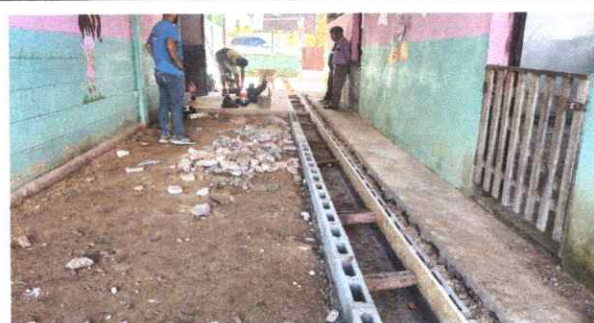
Foto 6: Reparación de cuneta de concreto
