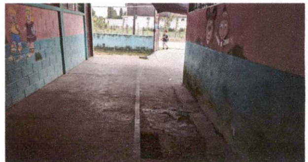
Foto 6: Reparación de cuneta de concreto
