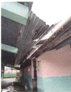
Foto 5: Sustrucción de soporte o pescante de metal para canal
