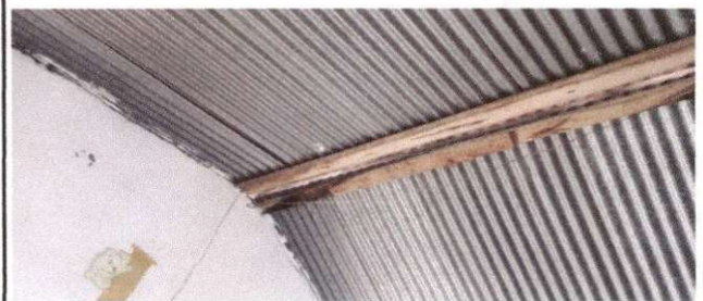
Foto 4: Sustrucción de lámina, por lámina troquelada aluzinc calibre 26
