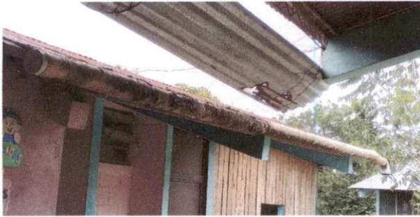
Foto 3: Mantenimiento a estructura de soporte de metal
