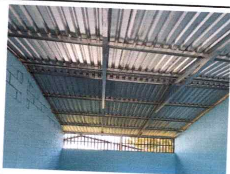
Foto 11: Sustrución de estructura de soporte de madera, por metal
