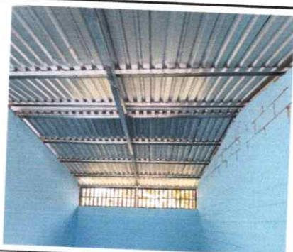
Foto 9: Sustrución de lámina por lámina troquelada aluzinc calibre 26
