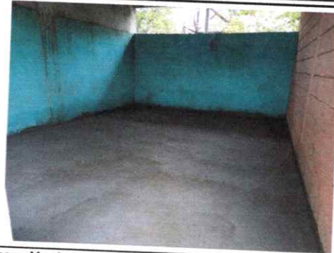
Foto2: Reparación de piso de torta de concreto
