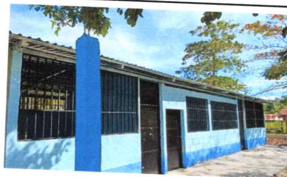
Foto 10: Sustrución de lámina por lámina troquelada aluzinc calibre 26
