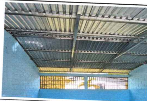
Foto 12: Sustrución de estructura de soporte de madera, por metal
