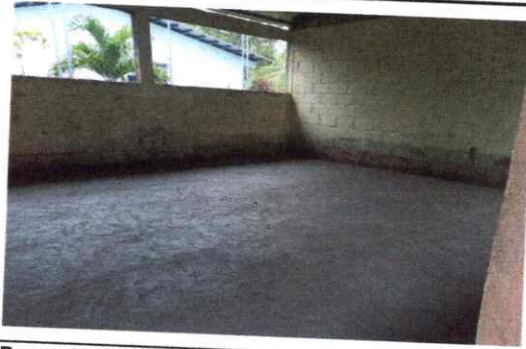
Foto1: Reparación de piso de torta de concreto
