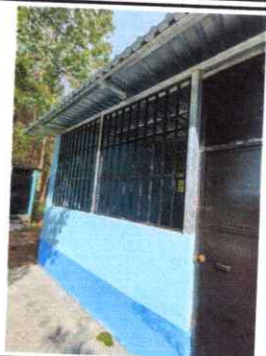
Foto 7: Sustrución de ventanas de madera por metal
