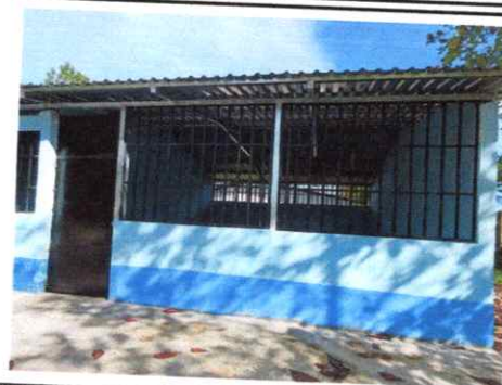
Foto 8: Sustrución de ventanas de madera por metal
