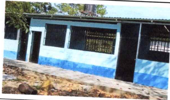
Foto 4: Fabricación e instalación de puertas de metal en módulos
