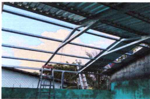
Foto 11: Sustitución de estructura de soporte de madera, por metal
