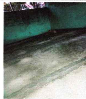
Foto2: Reparación de piso de torta de concreto
