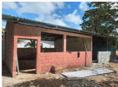
Foto 10: Sustitución de lámina por lámina troquelada aluzinc calibre 26
