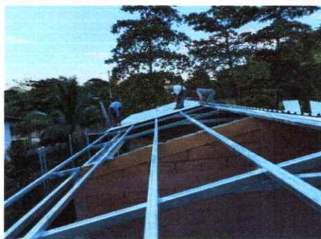
Foto 9: Sustitución de lámina por lámina troquelada aluzinc calibre 26
