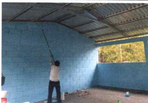
Foto 5: Pintura en muros exteriores e interiores
