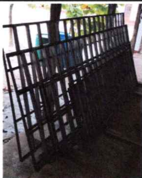
Foto 7: Sustitución de ventanas de madera por metal
