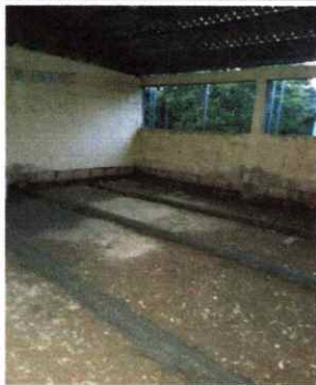
Foto1: Reparación de piso de torta de concreto
