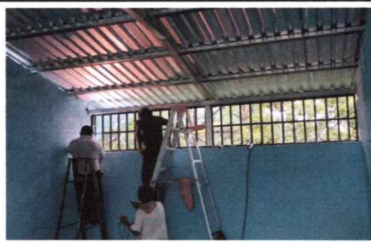
Foto 8: Sustitución de ventanas de madera por metal
