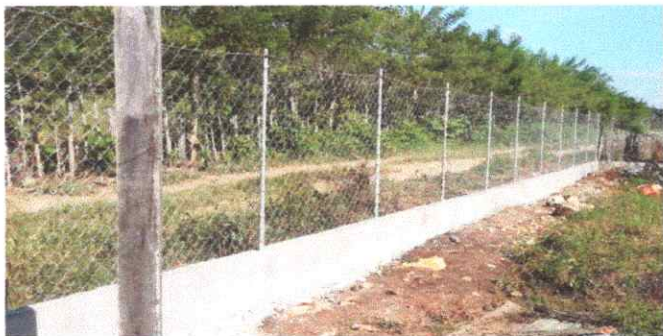
Foto 5: Reparación de cerco de alambre de puas
