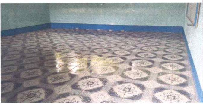
Foto 4: Reparación de piso de cemento liquido
