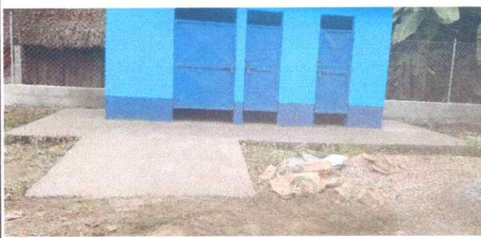
Foto 3: Reparación de Banqueta de concreto
