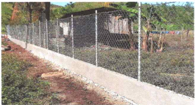
Foto 6: Reparación de cerco de alambre de puas
