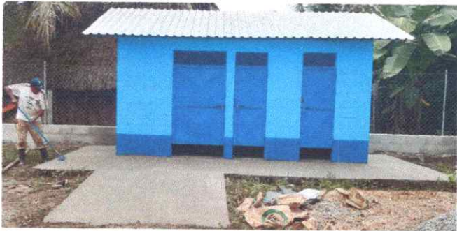
Foto 3: Reparación de Banqueta de concreto
