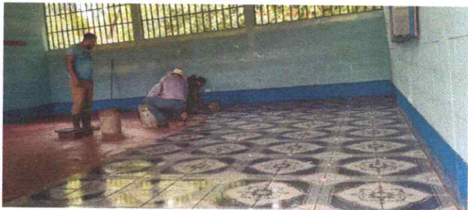
Foto 4: Reparación de piso de cemento líquido
