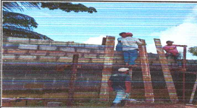
Foto 3: Reparación de muro perimetral de block
