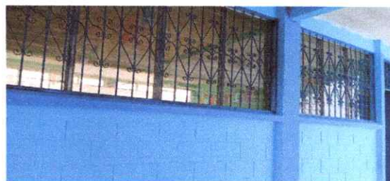
Foto 4: Mantenimiento de balcones
