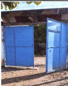
Foto1: Sustitución de portón
