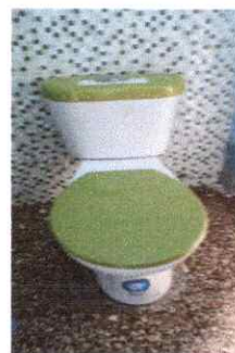
Foto 6: Sustitución de inodoros
