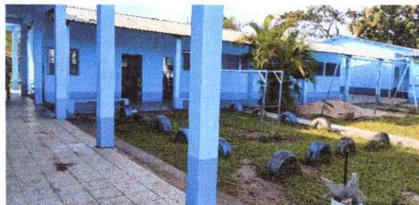
Foto 2: Pintado de paredes interiores y exteriores
