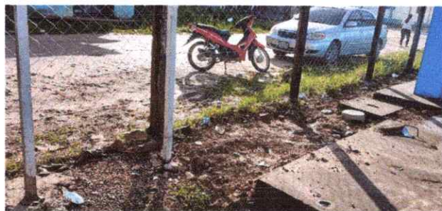
Foto 5: Tubería para drenaje
