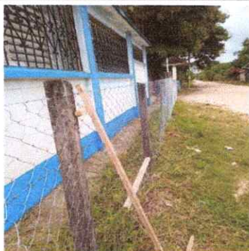
Foto 3: Cambio de alambre de pua
