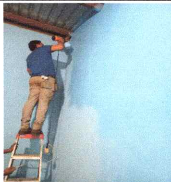
Foto 2: Pintado de paredes interiores y exteriores
