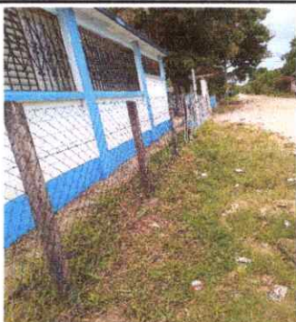
Foto 3: Cambio de alambre de pua
