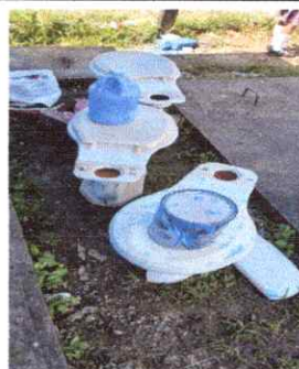
Foto 6: Sustitución de inodoros
