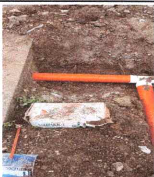
Foto 5: Tubería para drenaje
