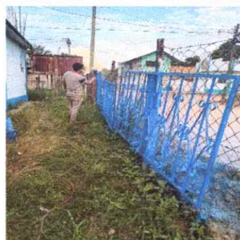
Foto 4: Mantenimiento de balcones
