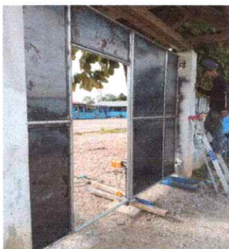
Foto1: Sustitución de portón
