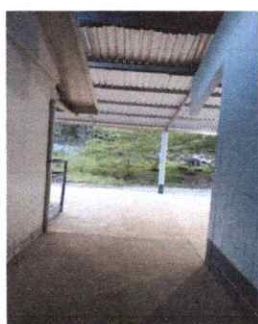
Foto 5: Instalación de lámina y estructura
