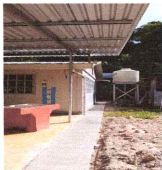
Foto 3: Instalacion de rotoplas y pila
