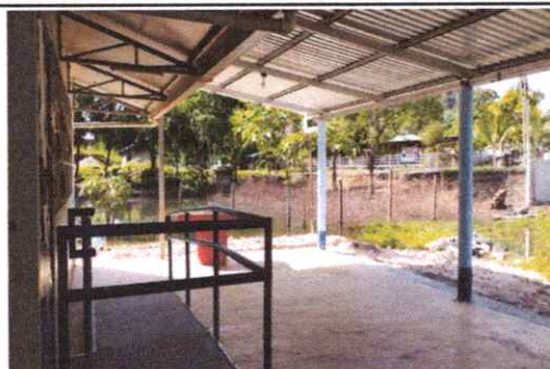
Foto 2: Trabajo terminado de piso, bajadas de agua y ceras
