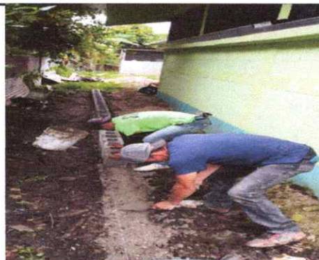
Foto 6: trabajando ya la banqueta de la parte de atrás de las aulas
