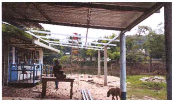
Foto 5: trabajando la estructura del techo
