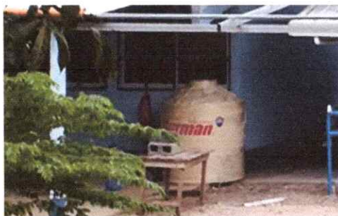
Foto 3: compra de rotoplas solo falta la instalación
