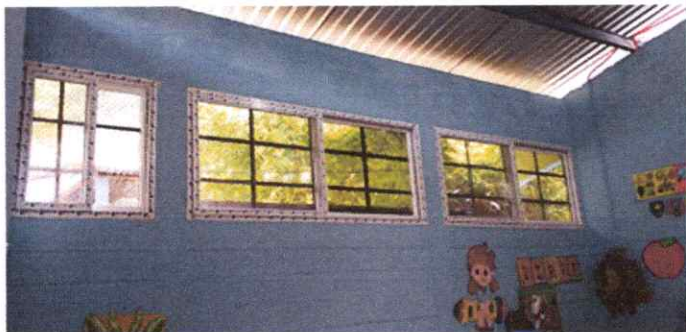
Foto1: ventanas de PVC ya instaladas
