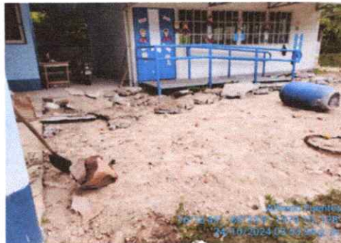
Foto 2: Arrancaron la torta de concreto para poder trabajar el piso liso
