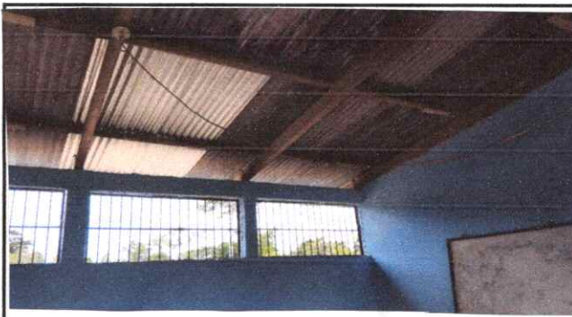
Foto 4: Reparación de cableado eléctrico
