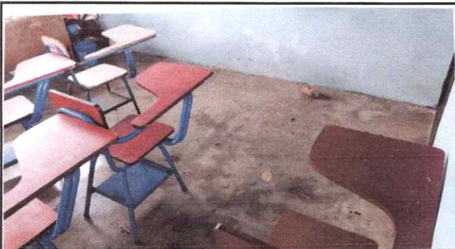
Foto 3: Sustitución de piso de cemento líquido
