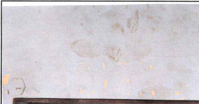
Foto 6: Pintura en muros exteriores e interiores
