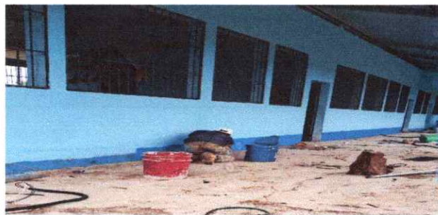
Foto 5: PINTURA EN MUROS INTERIORES Y EXTERIORES
