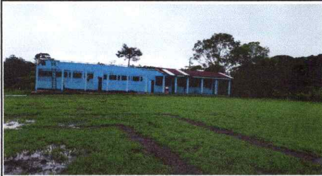
Foto1: SUSTITUCION DE LAMINA POR LAMINA TROQUELADA
