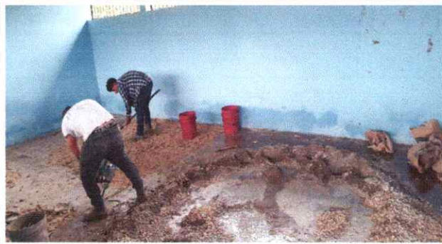
Foto 3: SUSTITUCION DE PISO DE CEMENTO LIQUIDO
