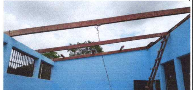
Foto 6: DESINSTALACION DE ESTRUCTURA PORTANTE DE MADERA
