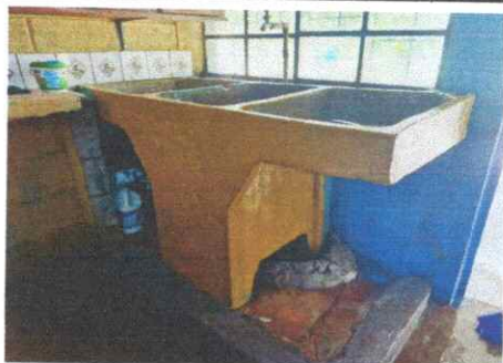
Foto: 7: Sustitución de pila de cemento de 2 lavaderos
