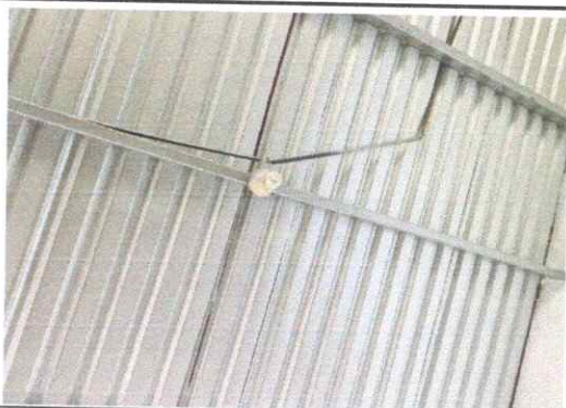
Foto 5: Reparación del sistema eléctrico
