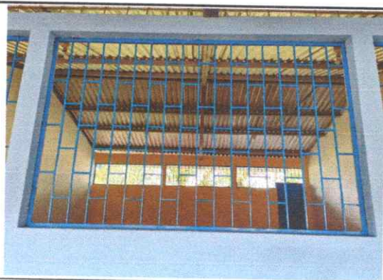
Foto 3: Sustición de estructura de metal de ventanas
