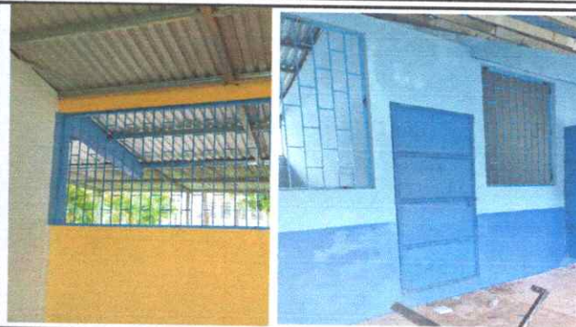
Foto: 8: pintura de muros exteriores e interiores
