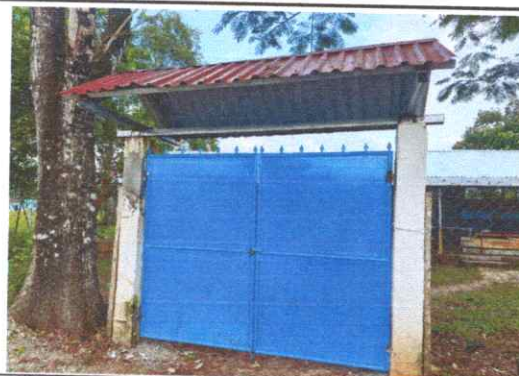
foto 6: Sustitución de portón
