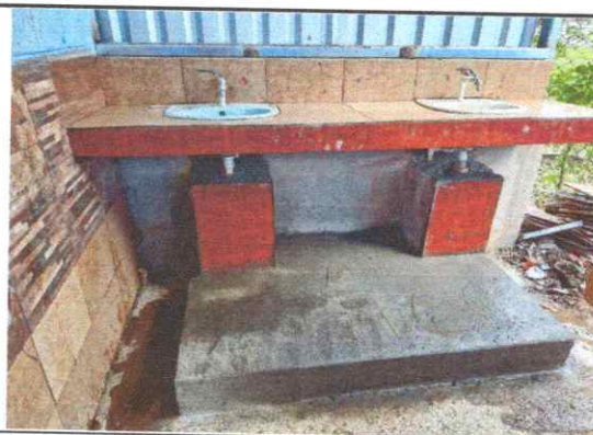
Foto 4: Sustitución de lavamanos
