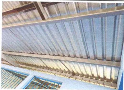
Foto 1: Reparación de cubierta de lamina
