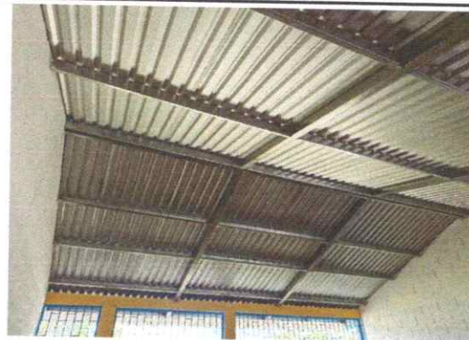
foto 2: Sustitución de estructura de techo
