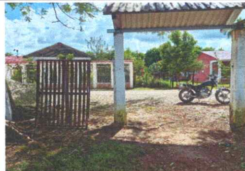
foto 6: Sustitución de portón
