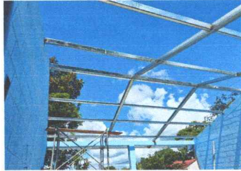
foto 2: Sustitución de estructura de techo
