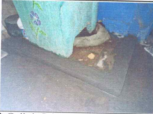
Foto 7: Sustrución de pila de cemento de 2 lavaderos
