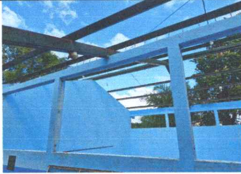
Foto 1: Reparación de cubierta de lamina
