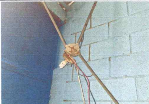
Foto 5: Reparación del sistema eléctrico
