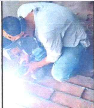
Foto 3: Sustitución de estructura de metal de ventanas
