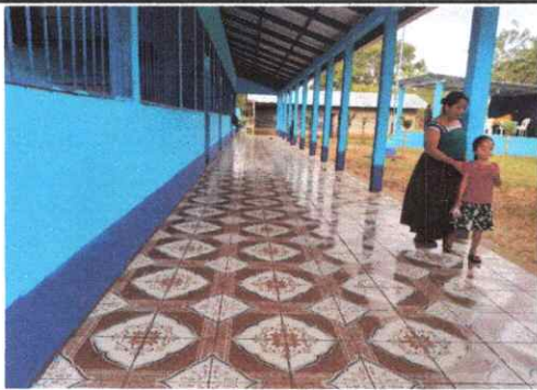
Foto 3: Pintura en Muros Interiores y exteriores
