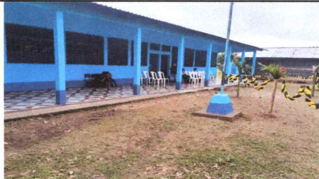
Foto 4: Pintura en Muros Interiores y exteriores
