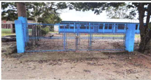
Foto 6: Mantenimiento a Portón de metal con malla
