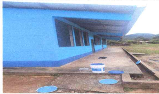
Foto 1: Pintura en Muros Interiores y Exteriores
