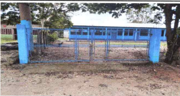
Foto 6: Mantenimiento a Portón de metal con malla
