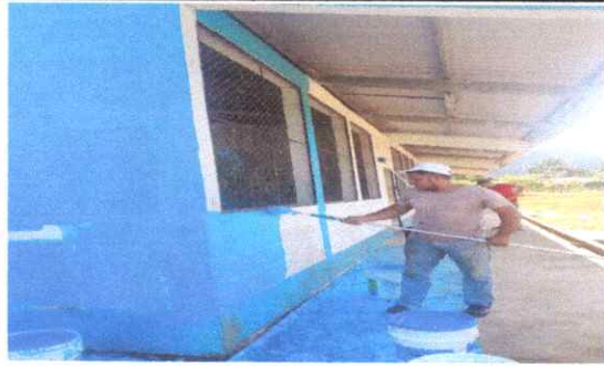
Foto 1: Pintura en Muros Interiores y Exteriores
