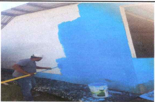
Foto 3: Pintura en Muros Interiores y exteriores
