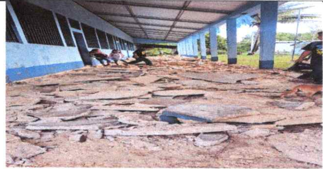
Foto 2: Reparación de piso de Torta de concreto por piso cerámico
