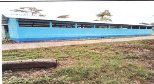
Foto 5: SUSTITUCION DE LAMINA TROQUELADA ALUZINC CALIBRE 26
