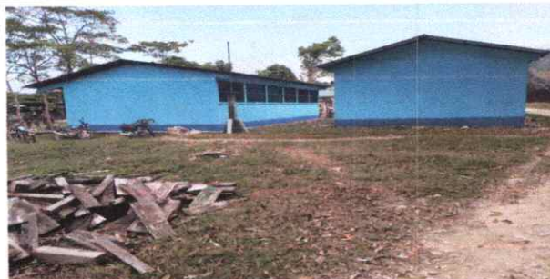
Foto 2: PINTURA DE MUROS EXTERIORES E INTERIORES
