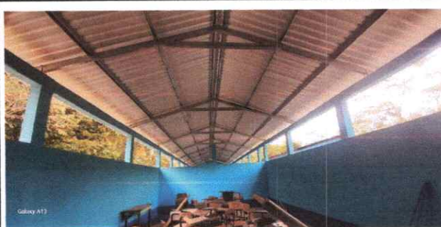
Foto 6: SUSTITUCION DE ESTRUCTURA DE SOPORTE DE MADERA POR METAL
