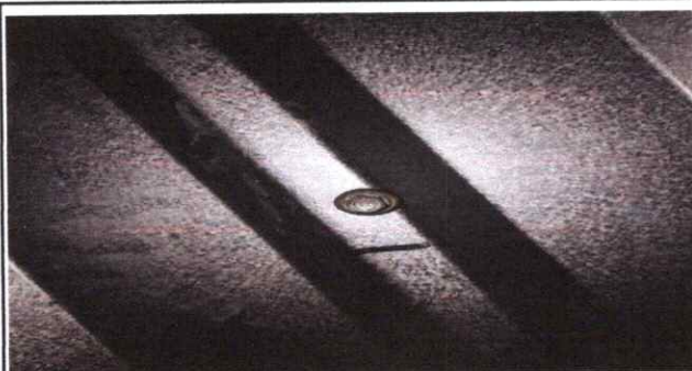
Foto 3: SUSTITUCION DE ELEMENTOS DE FIACION EN CUBIETA DE LAMINA
