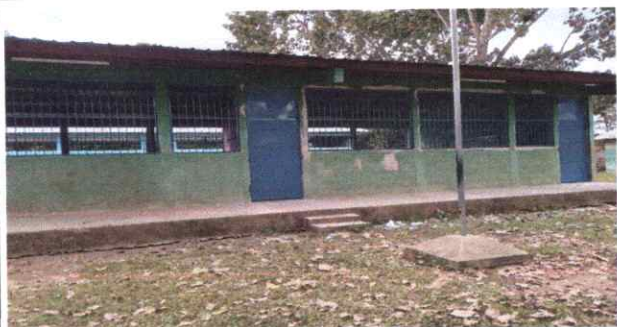
Foto 1: SUSTITUCION DE PUERTAS
