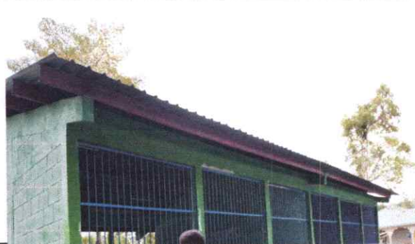
Foto 4: SUSTITUCION DE BALCONES DE METAL
