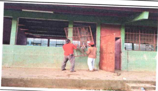
Foto 4: SUSTITUCION DE BALCONES DE METAL
