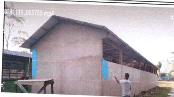
Foto 2: PINTURA DE MUROS EXTERIORES E INTERIORES
