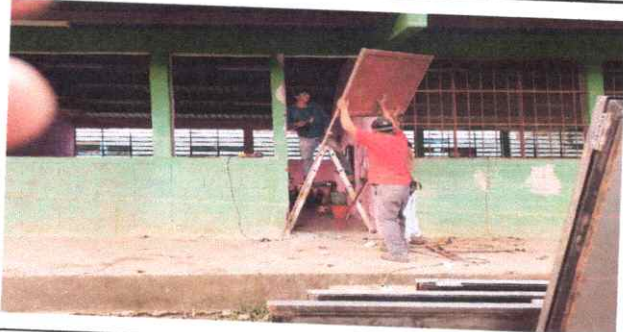
Foto 1: SUSTITUCION DE PUERTAS
