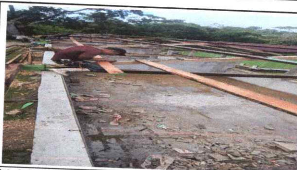
Foto 6: SUSTITUCION DE ESTRUCTURA DE SOPORTE DE MADERA POR METAL
