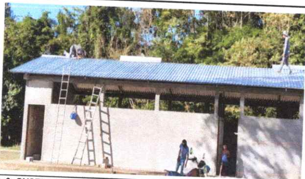
Foto 3: SUSTITUCION DE ELEMENTOS DE FIACION EN CUBIETA DE LAMINA
