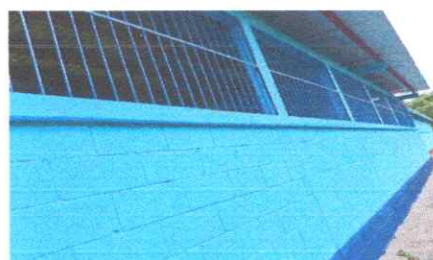
Foto 2: Sustitucion de Pintura en muros exterior e interior
