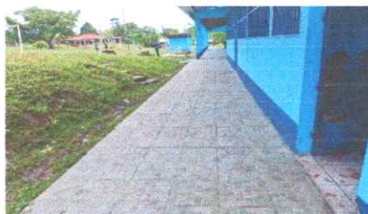
Foto 5: Sustitucion de pisos a ceramica
