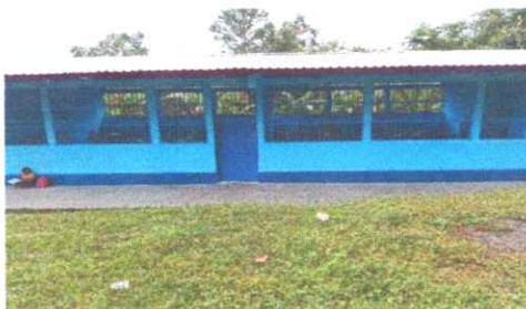
Foto1: Sustitucion de Balcones
