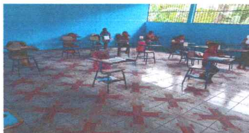
Foto 6: Sustitucion de piso de torta a ceramica
