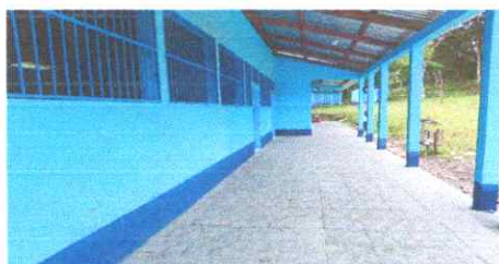
Foto 3: Sustitucion de pisos de torta a ceramica
